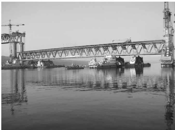
Рис. 2. Эпизод подъема второго пролета ульяновского моста (2007 г.)
