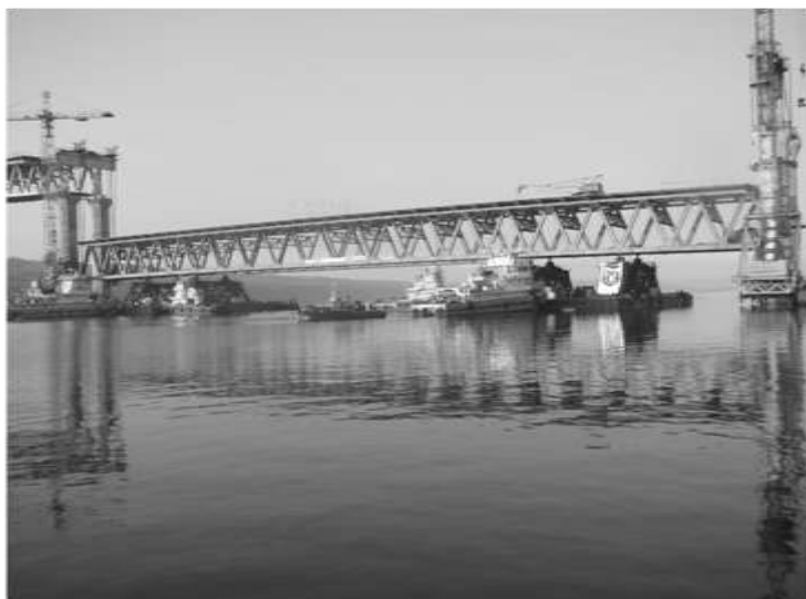
Рис. 2. Эпизод подъема второго пролета ульяновского моста (2007 г.)
